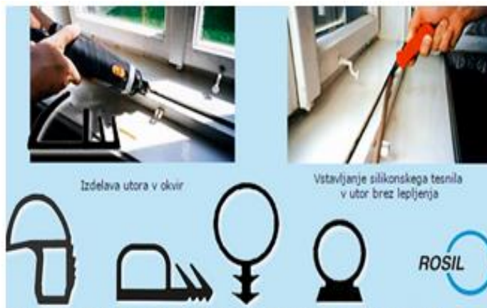
Izdelava utora in vgradnja silikonskih tesnil vir: katalog Rosil
