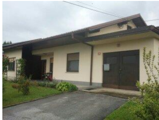
Slika2: Obravnavana pritlična stanovanjska hiša
